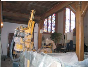
„Kirche ist immer Baustelle“ (Betonunterfütterung 2006)
