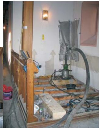
„Kirche ist immer Baustelle“ (Betonunterfütterung 2006)
